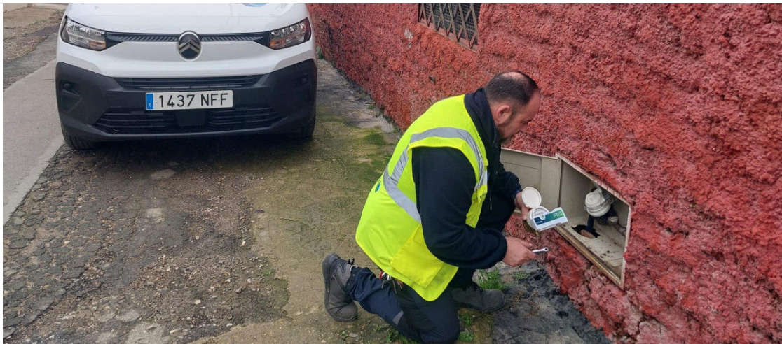
Instalación de contadores inteligentes de EmacsaLa Voz
